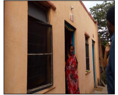
मांग गारुडी कुटुंबाला घरकुल योजनेत मिळालेले घर (थेऊर गाव)
